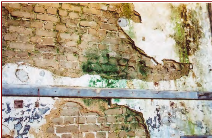
Εικόνα 4.15. Διαβρωμένες οπτοπλινθοδομές στο ισόγειο της «Υφανέτ». (Φωτογραφία: Τσόλης Ευστάθιος, Ιανουάριος 2003).
