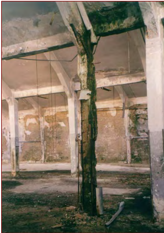
Εικόνα 4.14. Μια από τις αποσαθρωμένες κολώνες στο ισόγειο της «Υφανέτ». (Φωτογραφία: Τσόλης Ευστάθιος, Ιανουάριος 2003).
