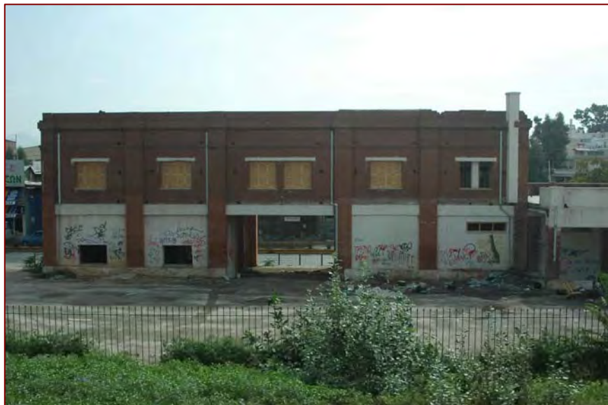
Εικόνα 4.19. Άποψη της πίσω όψης του κτιρίου Δηλαβέρη. (Φωτογραφία: Τσόλης Ευστάθιος, Οκτώβριος 2004).
