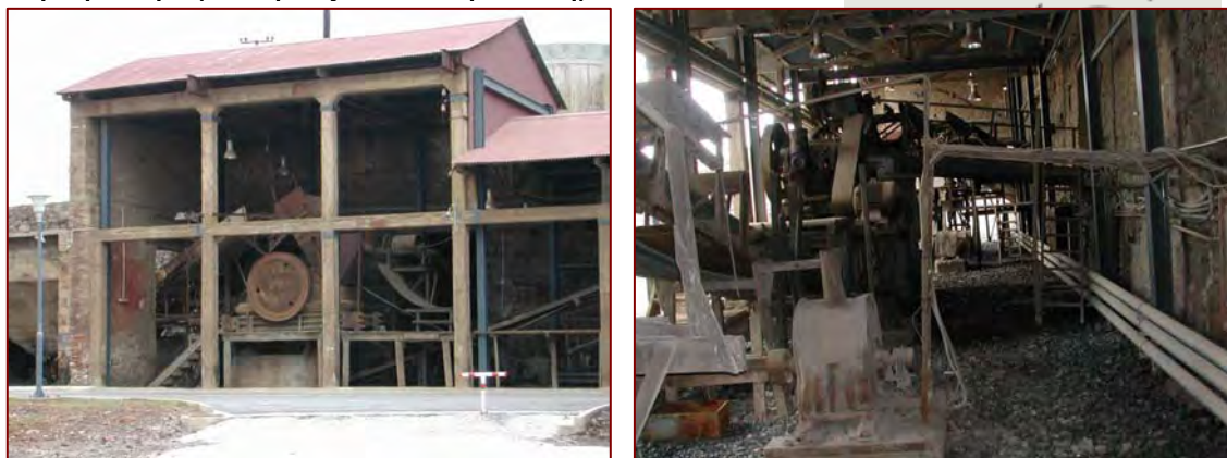
Εικόνες 4.39-40. Το κτίριο των θραυστήρων. (Φωτογραφίες: Παπαδημητρίου Ιωάννα, Δεκέμβριος 2002).
