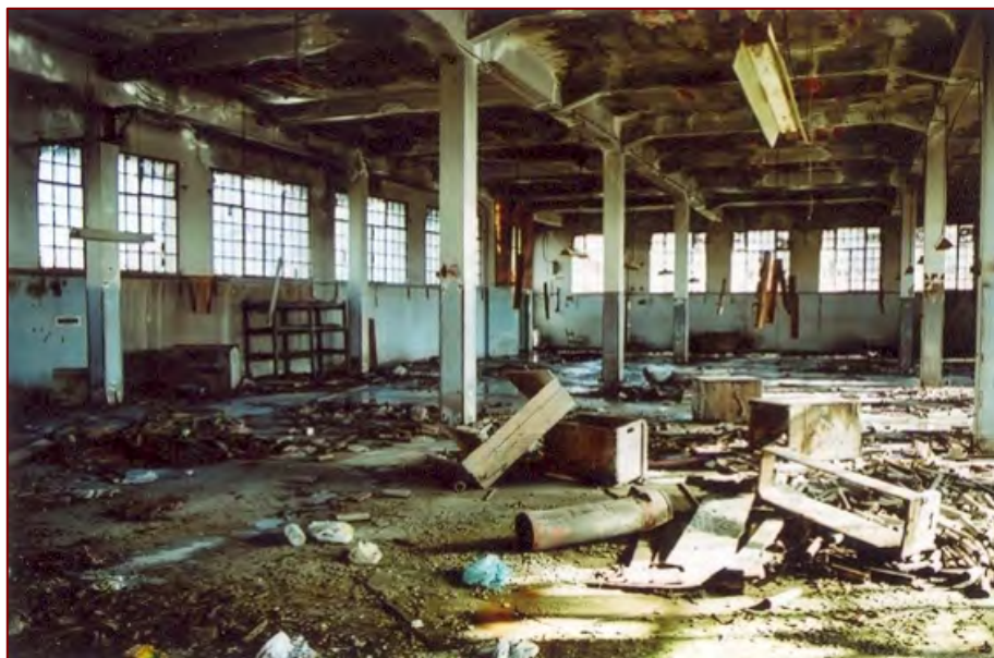
Εικόνα 4.12. Το εσωτερικό του ισογείου της «Υφανέτ». (Φωτογραφία: Τσόλης Ευστάθιος, Ιανουάριος 2003).
