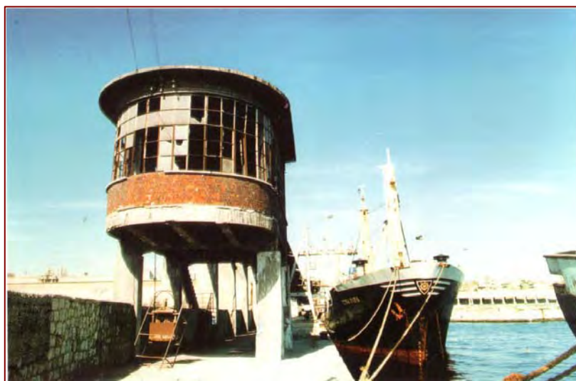
Εικόνα 4.7. Ταινιόδρομος φόρτωσης της Εταιρίας Λιπασμάτων στην είσοδο του λιμανιού του Πειραιά (Πηγή: Πολύζος Γιάννης, Παναγιωτόπουλος Βασίλης, (1998), Ιστορικός βιομηχανικός εξοπλισμός στην Ελλάδα , ..., σ. 18).
