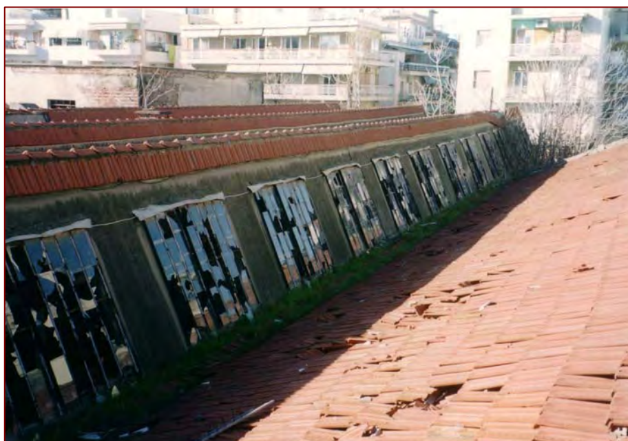
Εικόνα 4.13. Η οδοντωτή στέγη της «Υφανέτ». (Φωτογραφία: Τσόλης Ευστάθιος, Ιανουάριος 2003).
